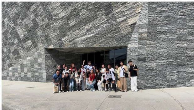
KADOKAWA が展開する「ところざわサクラタウン」のランドマーク
